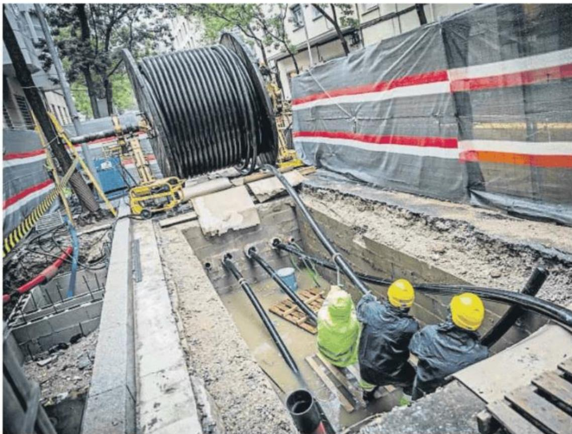
Los operarios lanzan el cable a través de una bobina en una de las zanjas abiertas en la calle
